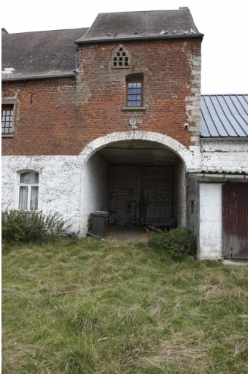
Détail du pigeonnier-porche depuis la cour.
