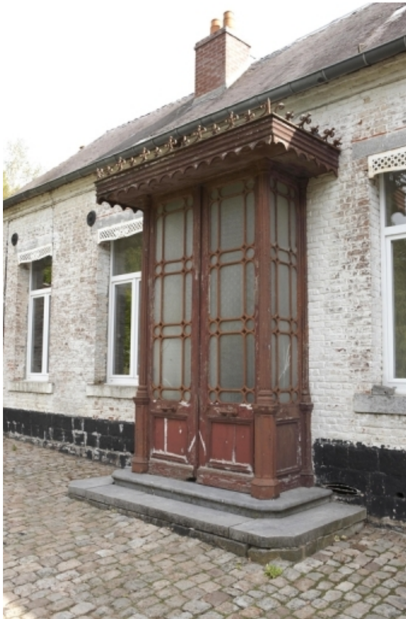
Détail du porche vitré hors-oeuvre en menuiserie.
