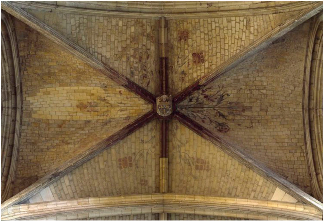
Détail de la voûte du bras sud du second ou petit transept.
