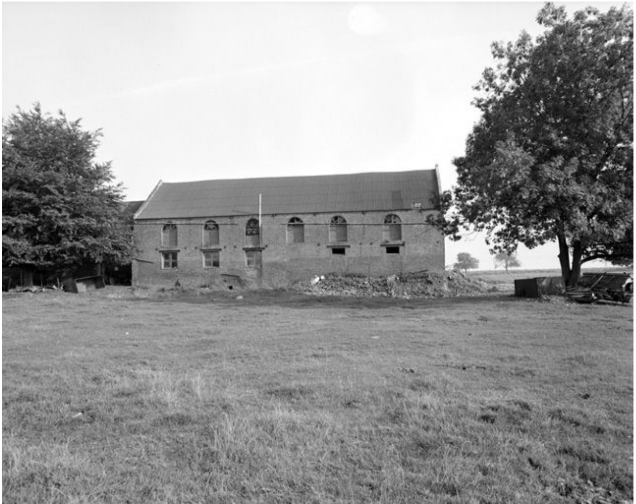
Élévation postérieure de l'atelier de fabrication.
