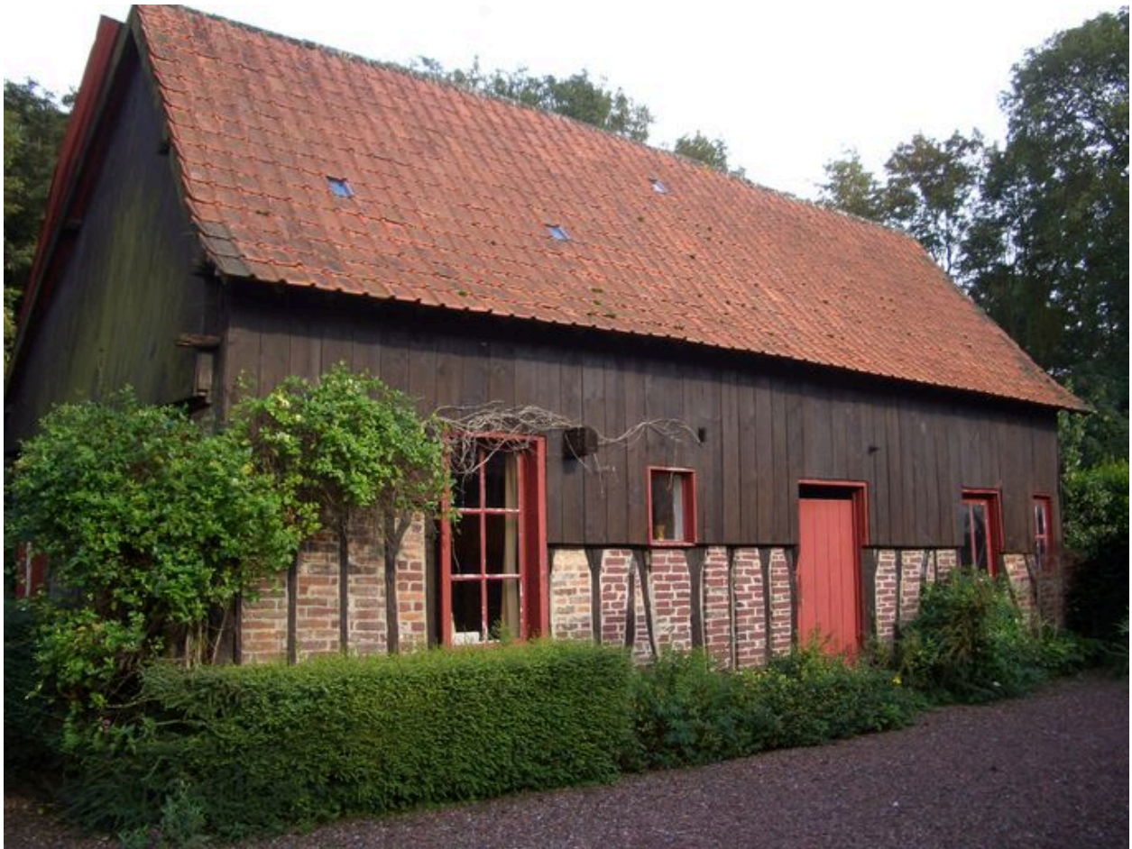
Vue de l'ancien atelier.
