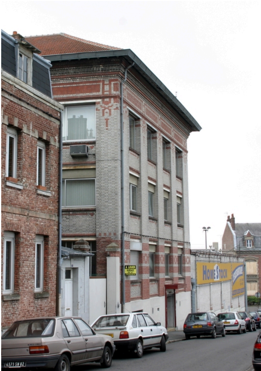
Vue des anciens magasins et ateliers, rue de la Tour Sainte-Catherine.
