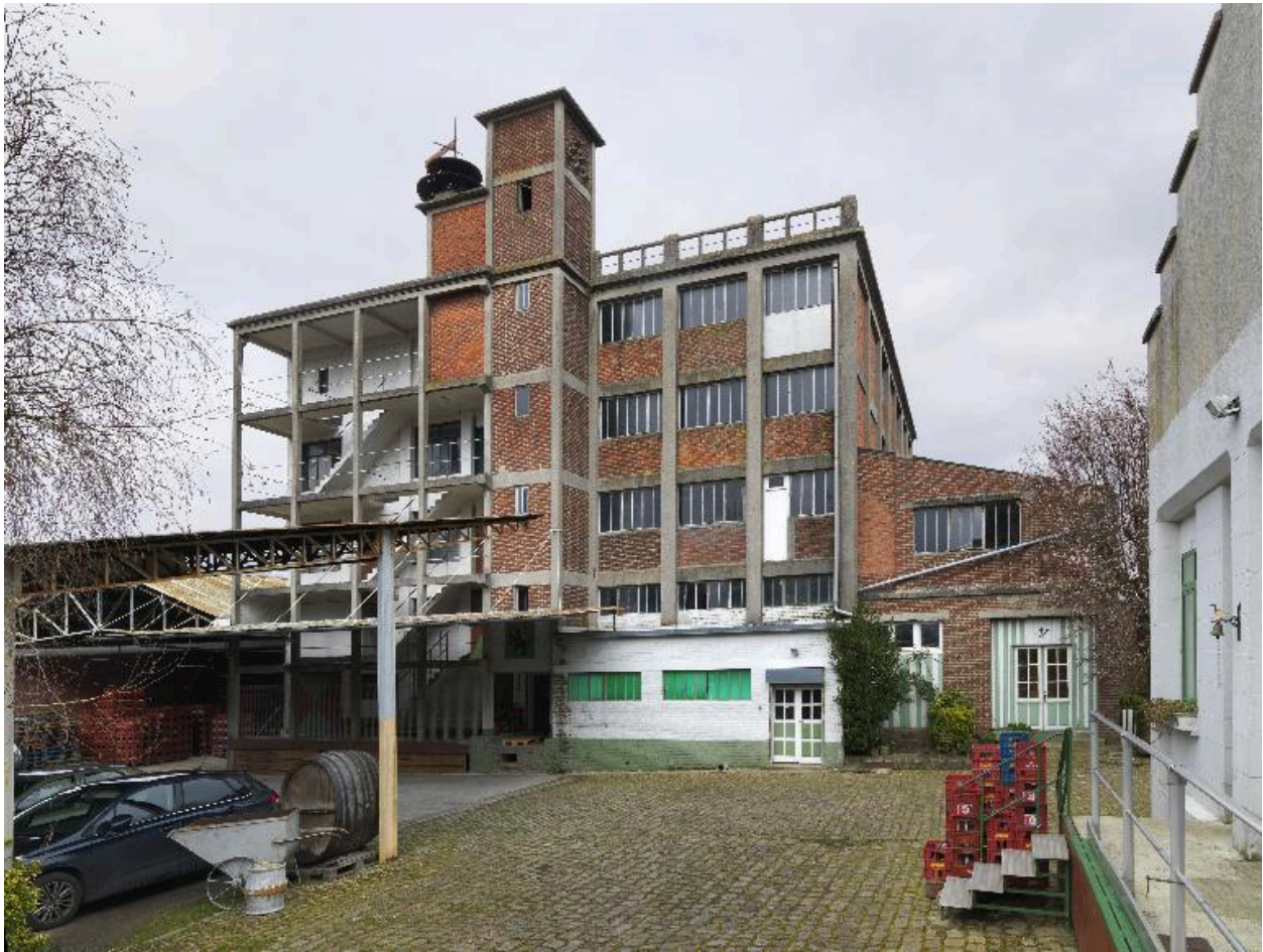
Vue d'ensemble sur cour de la brasserie.
