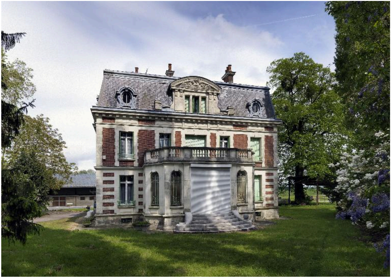
Vue de la façade du château.
