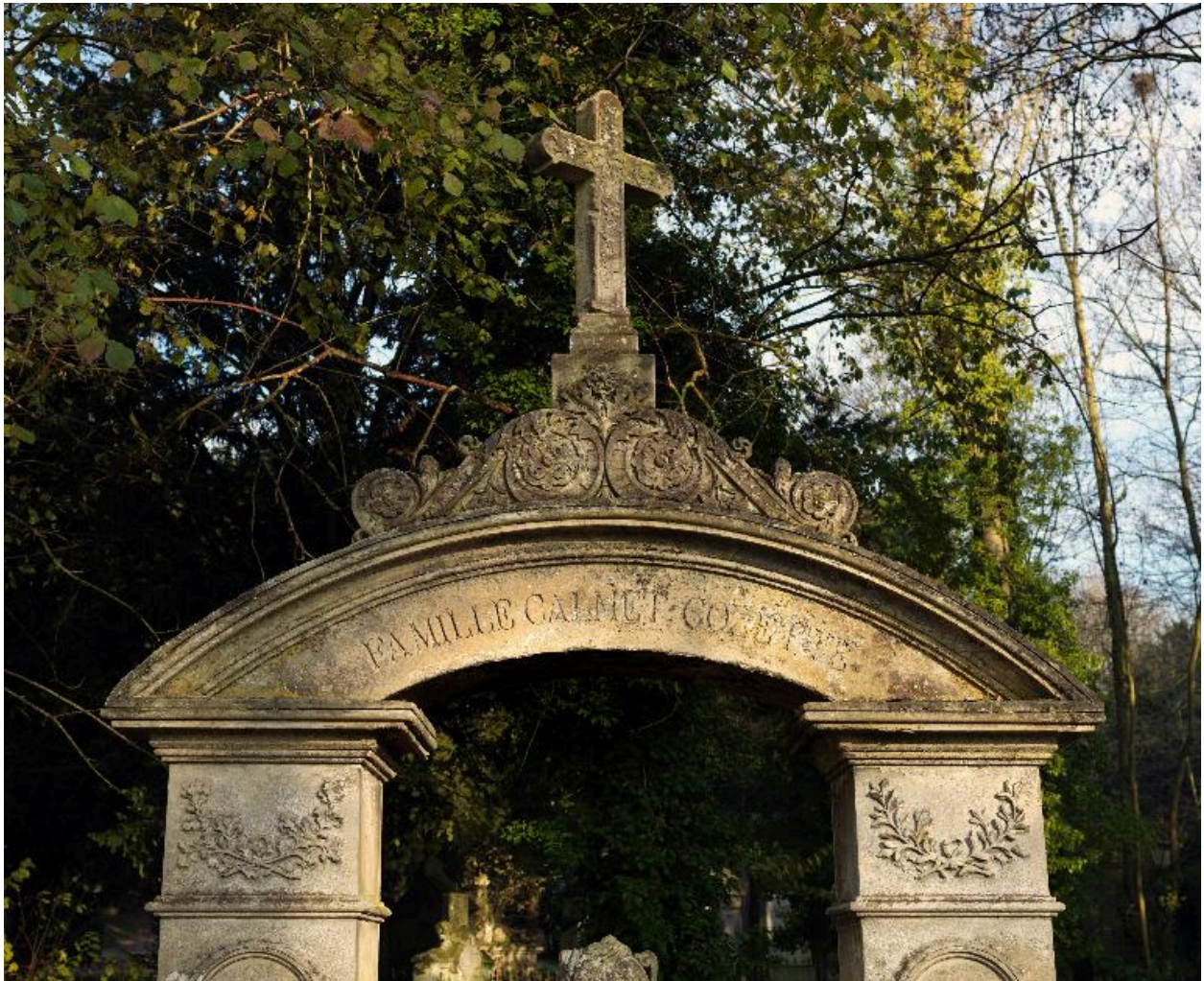
Vue de détail de la partie supérieure de l'arc.
