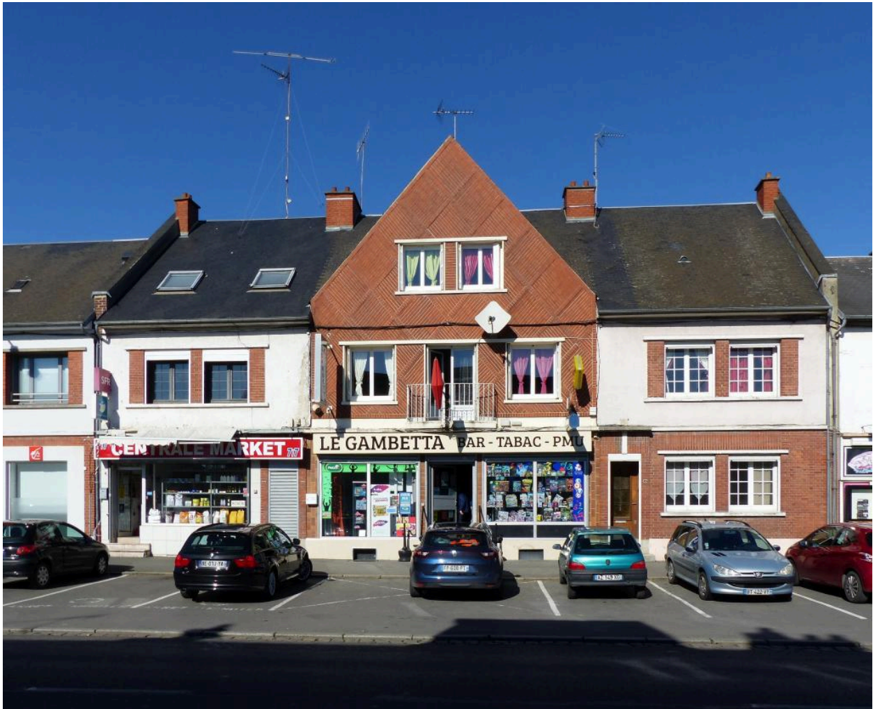
Partie centrale du groupe est, 4 à 10 boulevard Gambetta.
