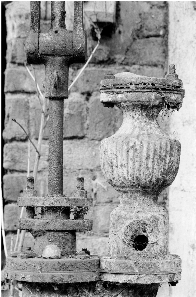
Pompe extérieure de la brasserie, détail.
