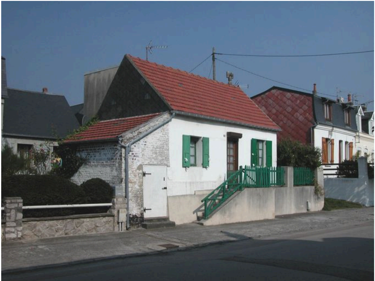
Une maison ancienne, 23 avenue Carnot (1988 BA 175).
