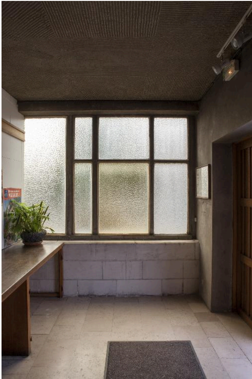
Vue de l'entrée de l'église.
