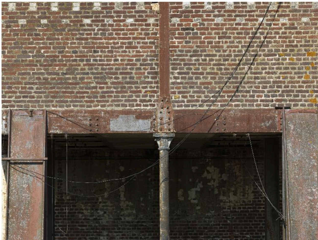
Détails d'une des colonnes en fonte supportant la structure métallique du bâtiment de production.
