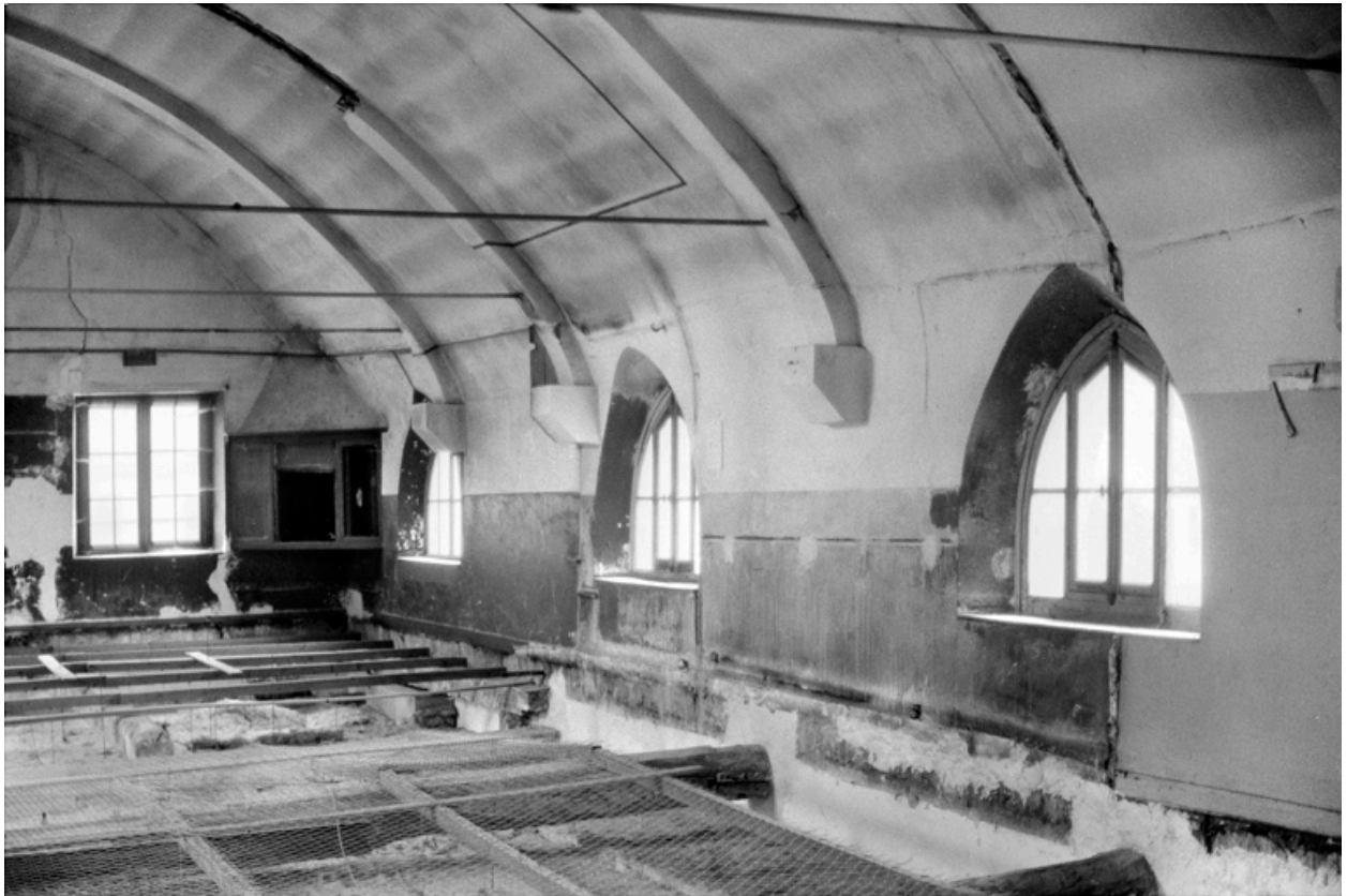
Vue de la chapelle : charpente.
