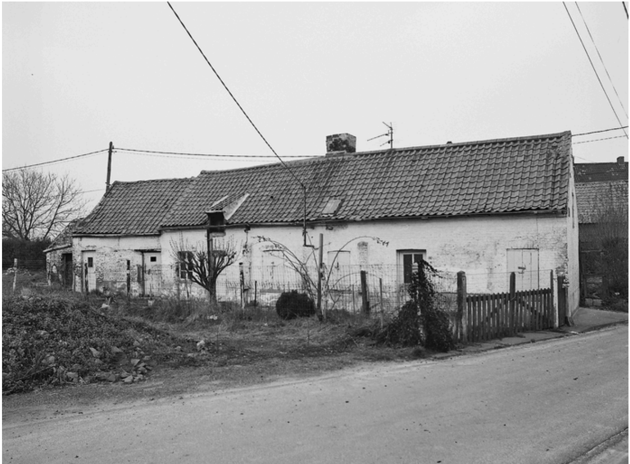
Ferme élémentaire, 12, rue du Fort.
