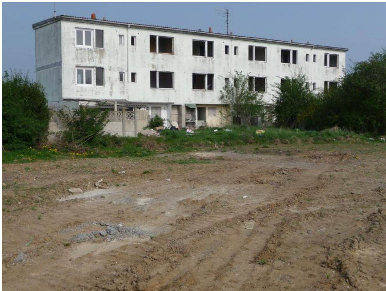
Vue générale d'un groupe de six logements.
