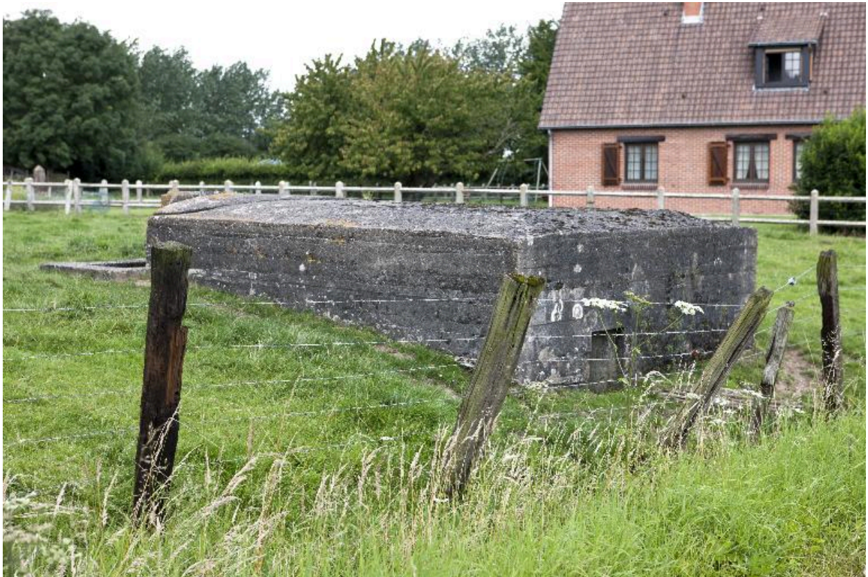
Vue vers le nord-ouest
