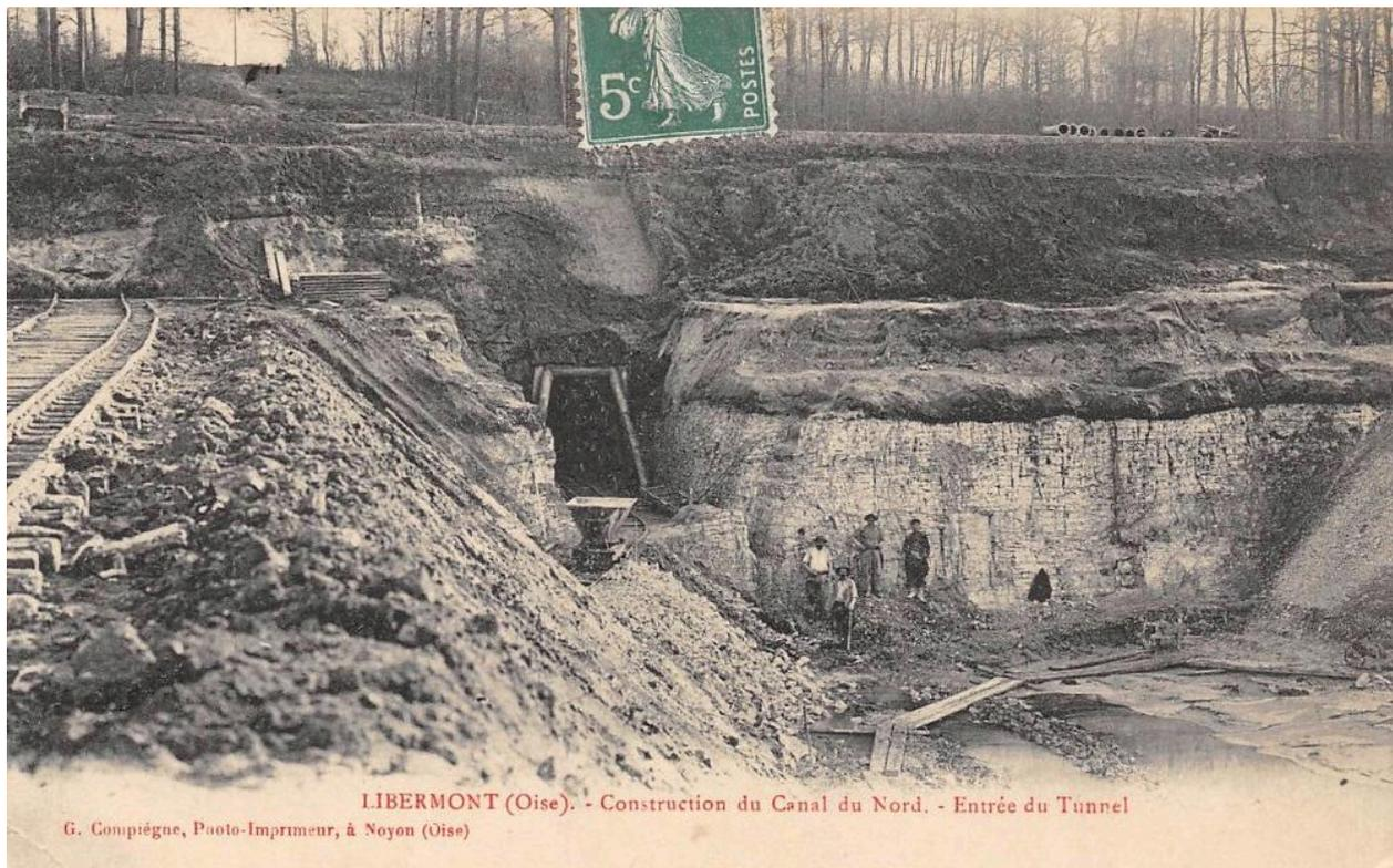
Entrée nord du souterrain de la Panneterie en cours de construction à Libermont (Oise).
