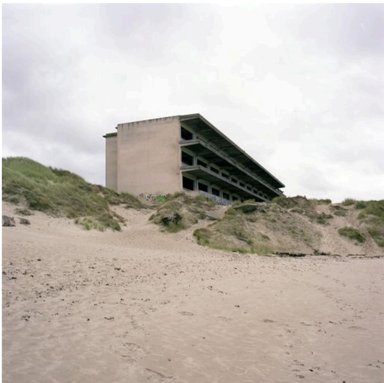
Élévation antérieure, vue générale prise en enfilade depuis le nord.
