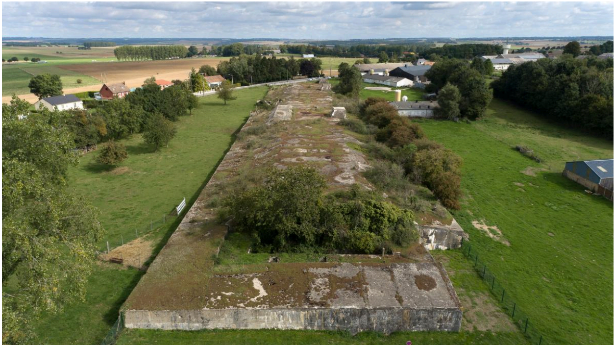
Vue aérienne longitudinale et oblique, vers le nord-est.
