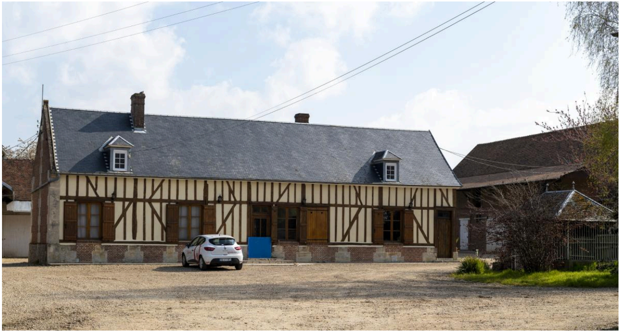
Logis de ferme, n°1 rue Claude, vue depuis le sud-ouest.
