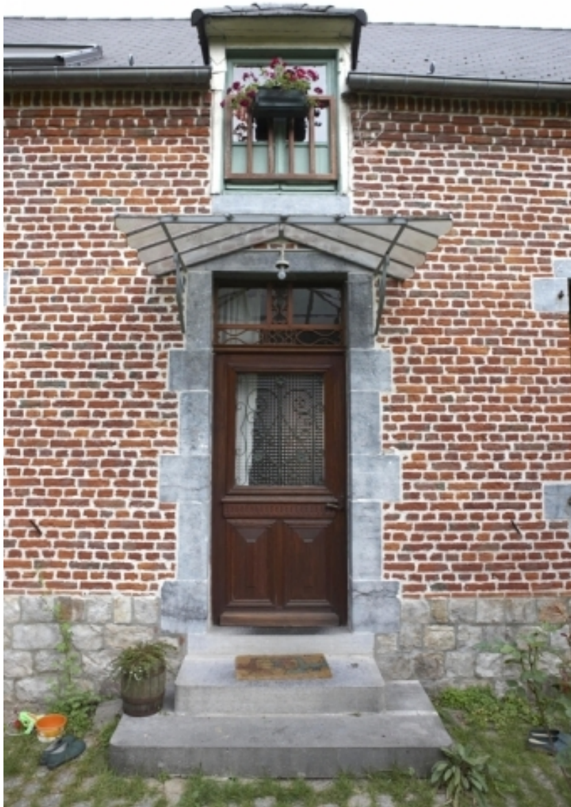
Détail de la porte du logis.
