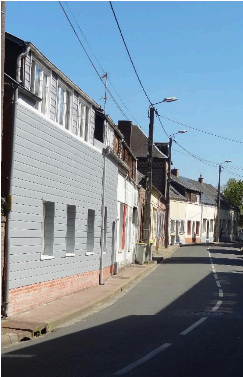
Vue générale depuis l'ouest de la rue Jean-Catelas.
