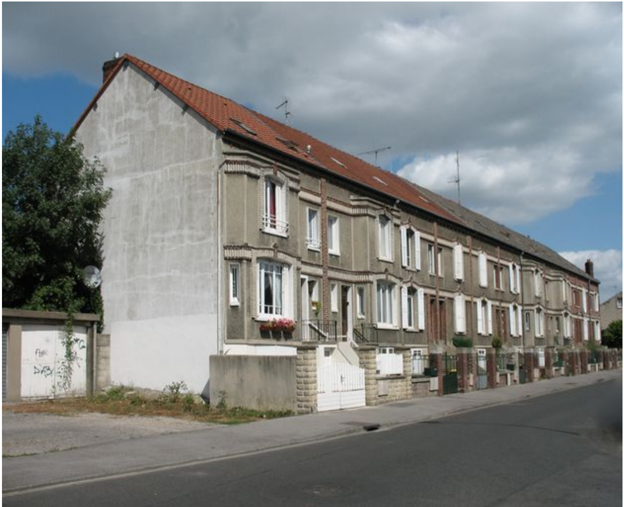
Ensemble de logements en bande rue Claude Péroche : la maison de l'ingénieur se trouve à l'extrême gauche.
