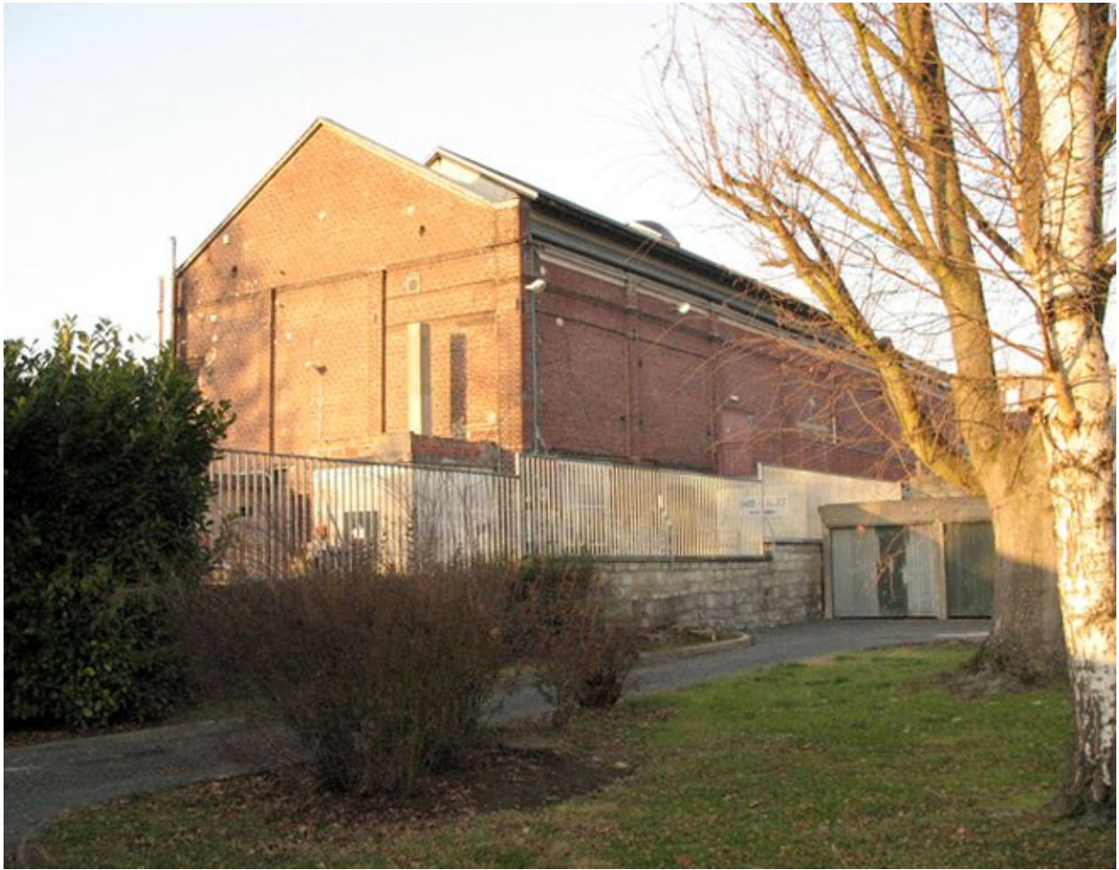
Façade sud-est de la salle des fêtes.
