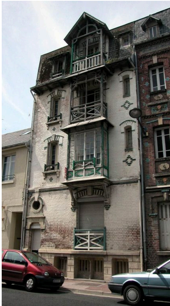
Vue d'ensemble avant travaux (été 2003).
