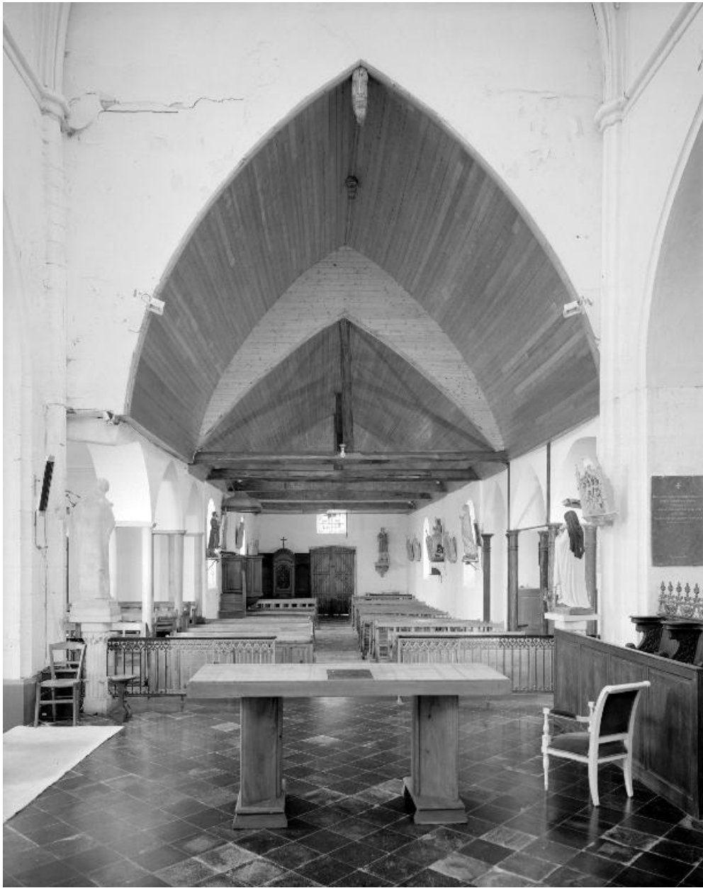
Vue intérieure de l'église, depuis le chœur.
