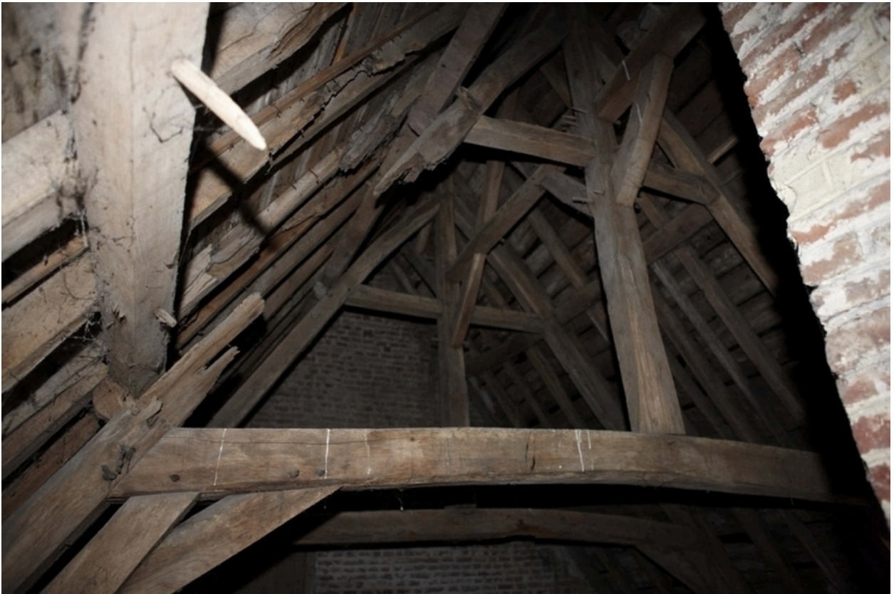
Détail de la charpente du logis.
