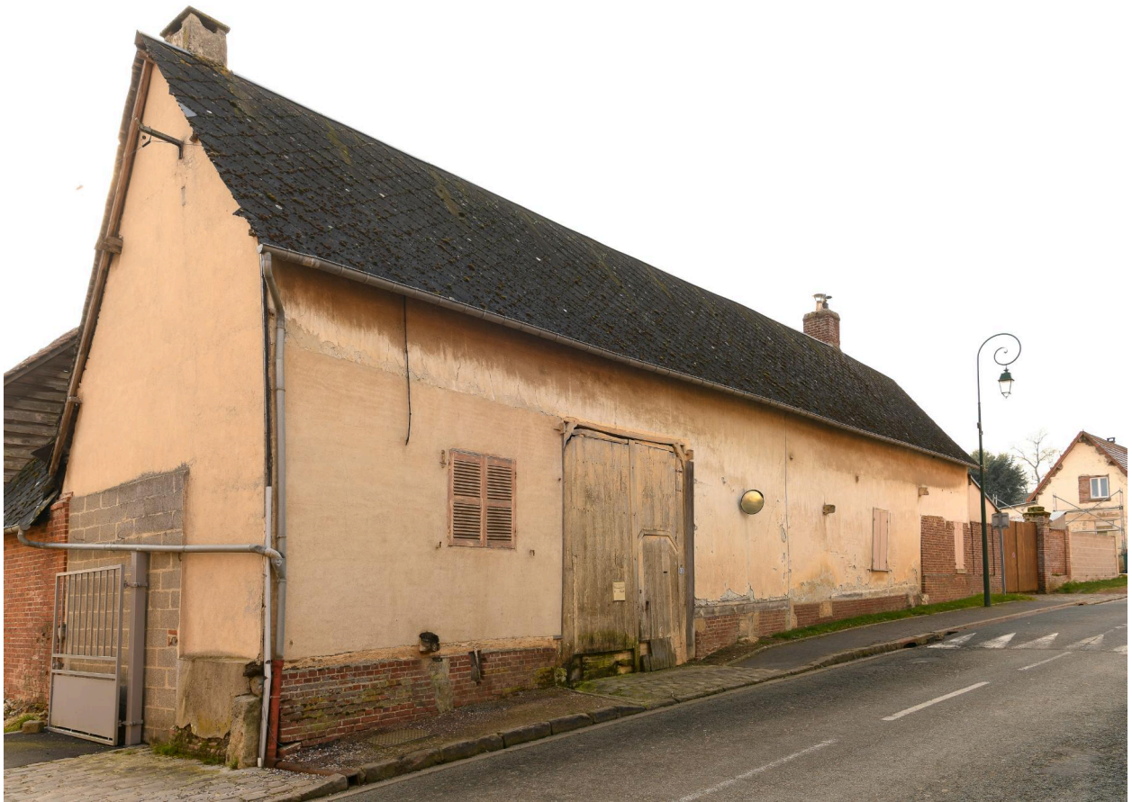
Grange avec atelier sur rue (?), n°31 rue de la Chaussée, vue prise depuis le nord.
