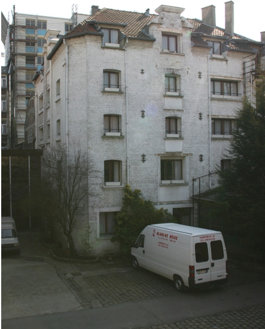
Bâtiment de l'ancienne brasserie, orienté sur la cour.
