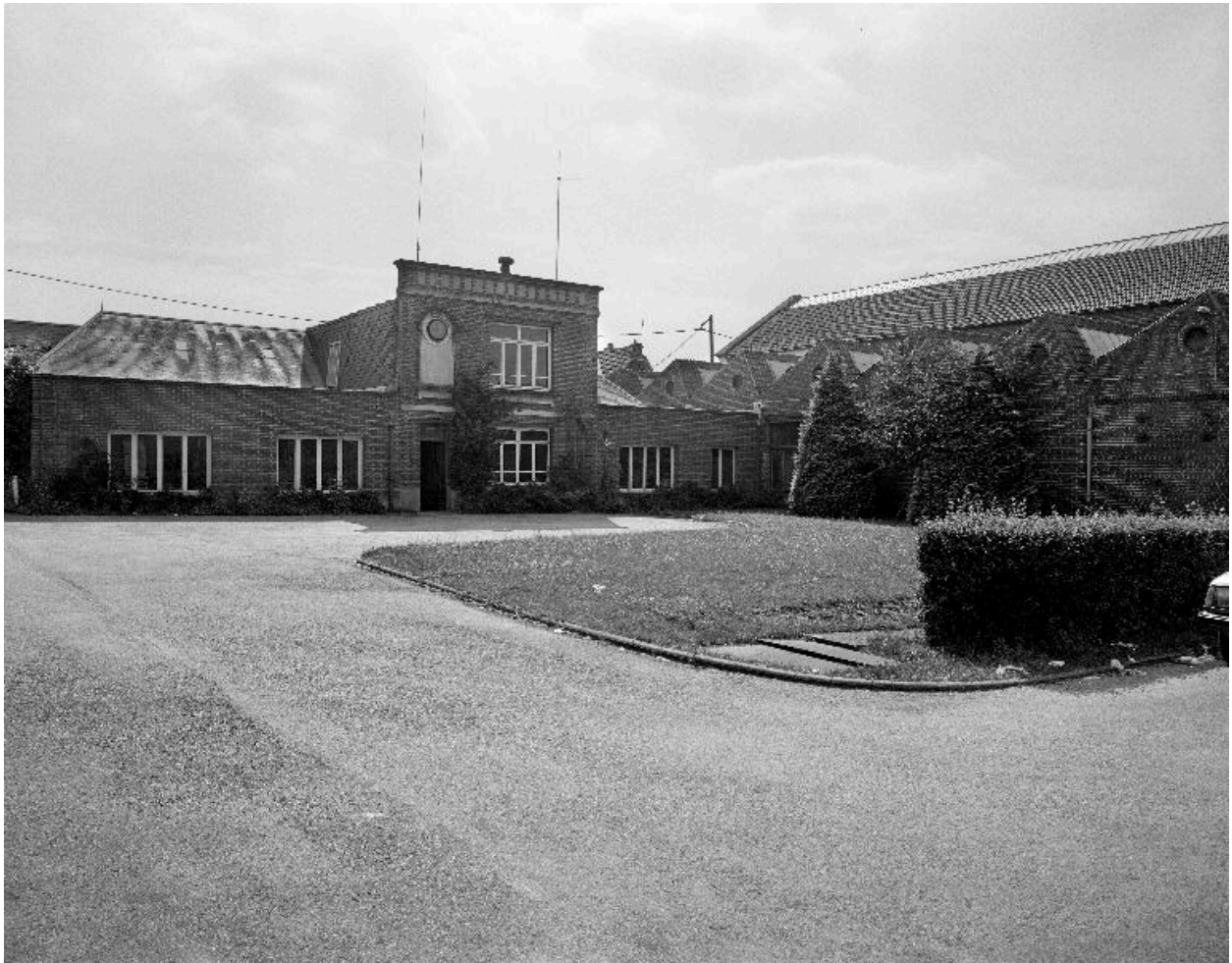
Bureau, flanc nord.
