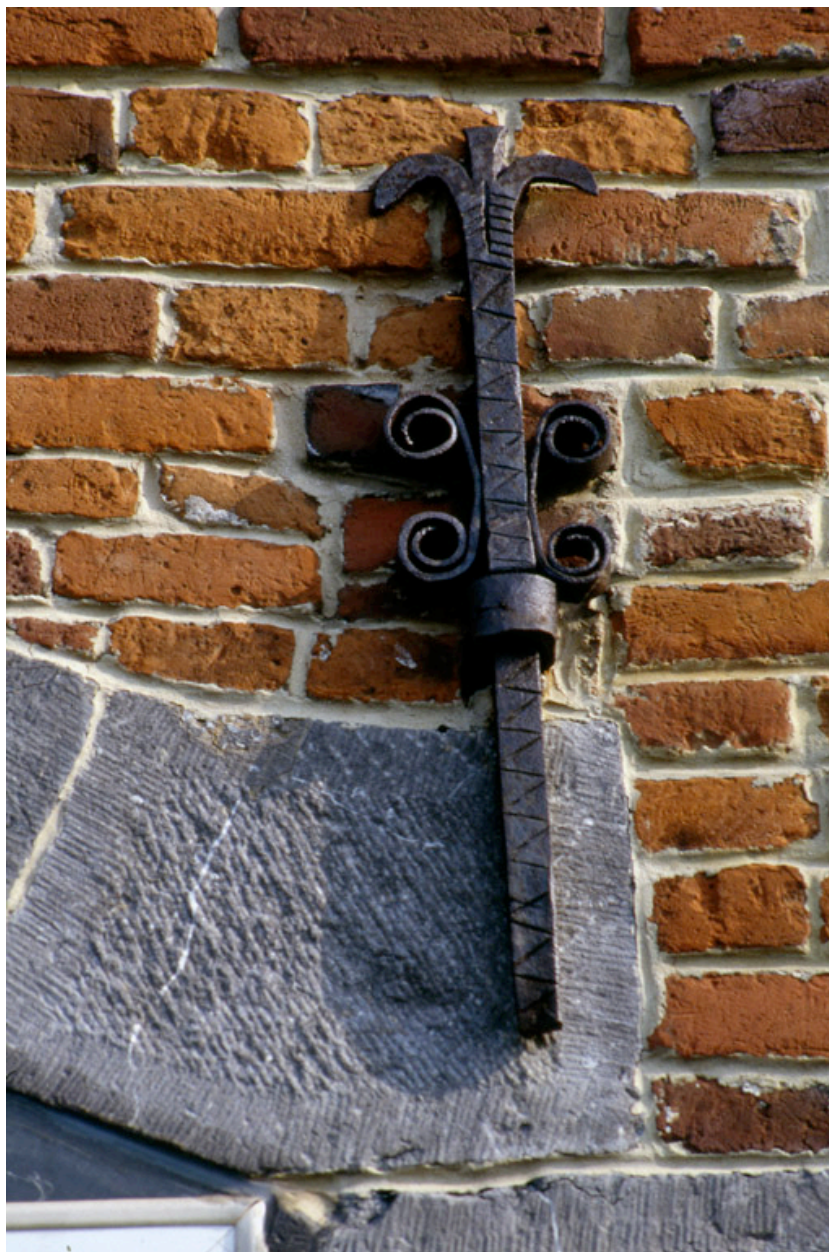
Barzy-en-Thiérache, maison (repérée), 57 Grande-Rue : fer d'ancrage de la façade (chiffre 1).
