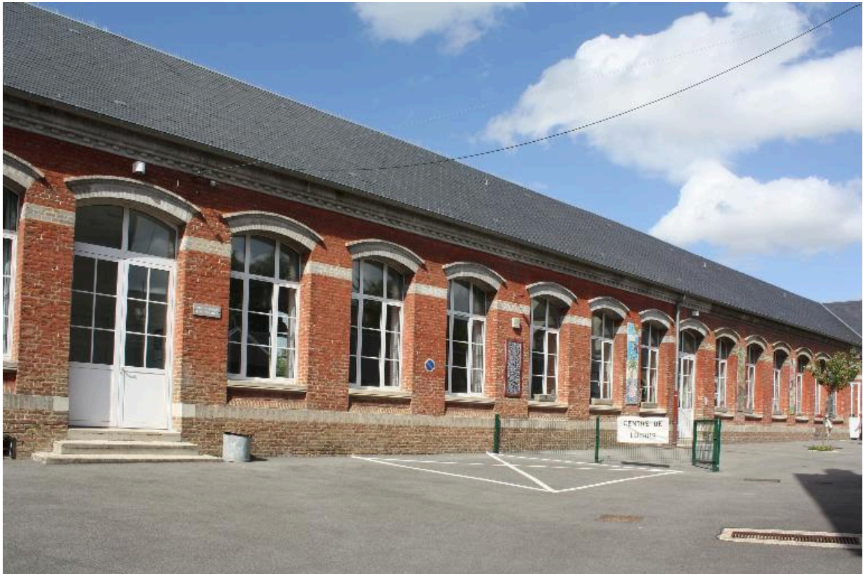
Façade sur cour.
