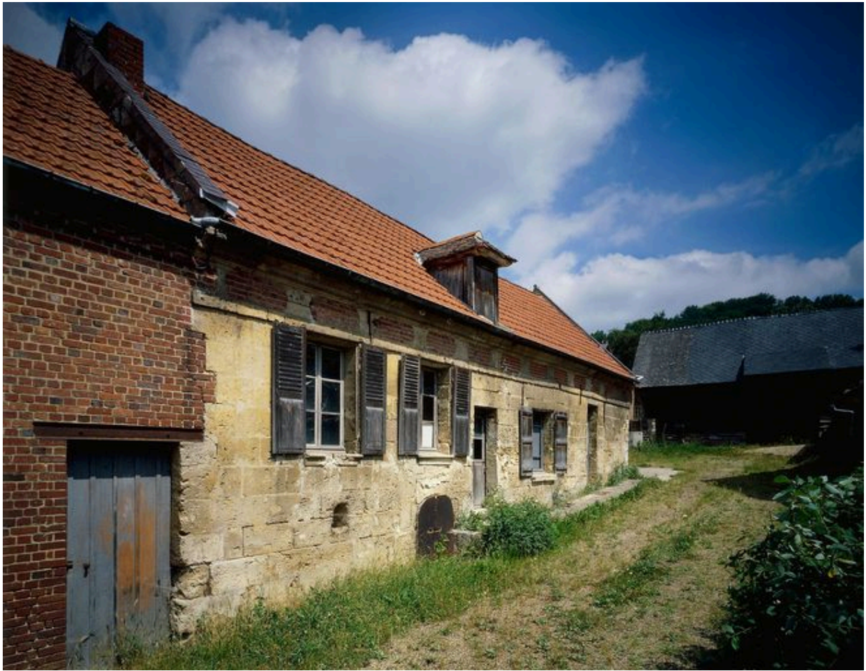
Logis. Elévation antérieure.
