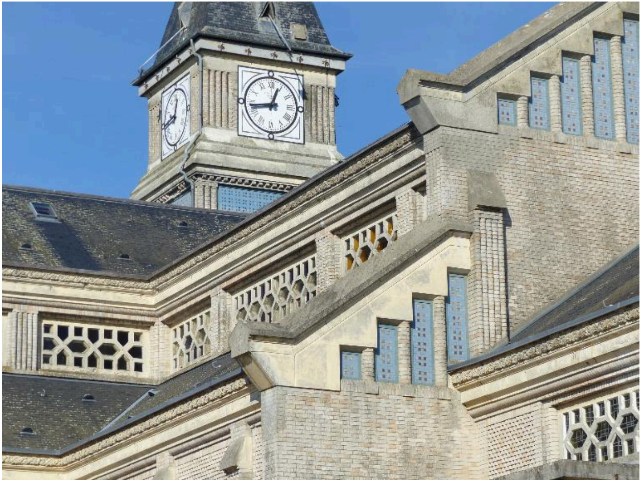
Vue de détail des toitures.
