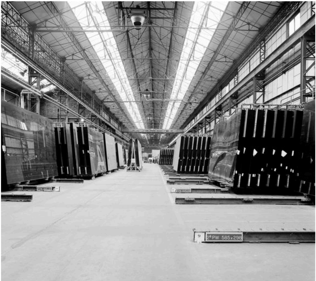
Intérieur d'un des magasins de stockage des vitres, vue d'ensemble.
