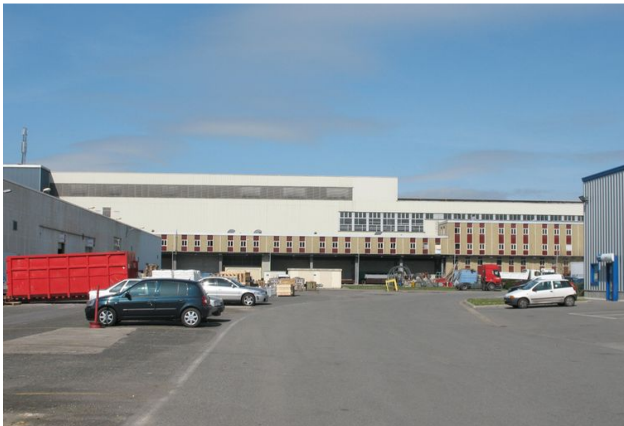
Façade de la chaîne de préparation des fonds de véhicules.
