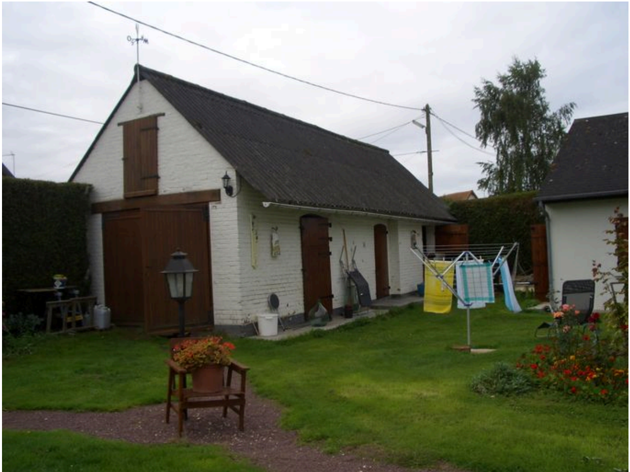
Vue des écuries sur rue.
