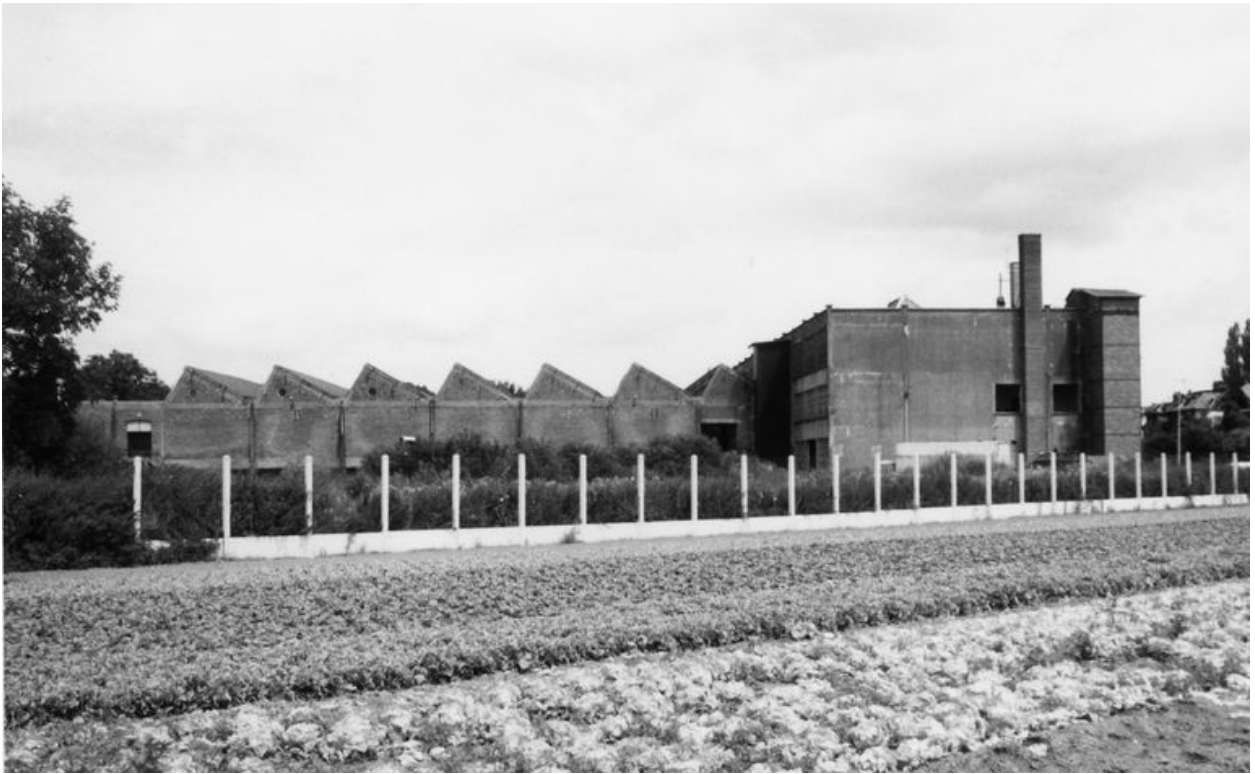
Atelier de fabrication (tissage), flanc sud.
