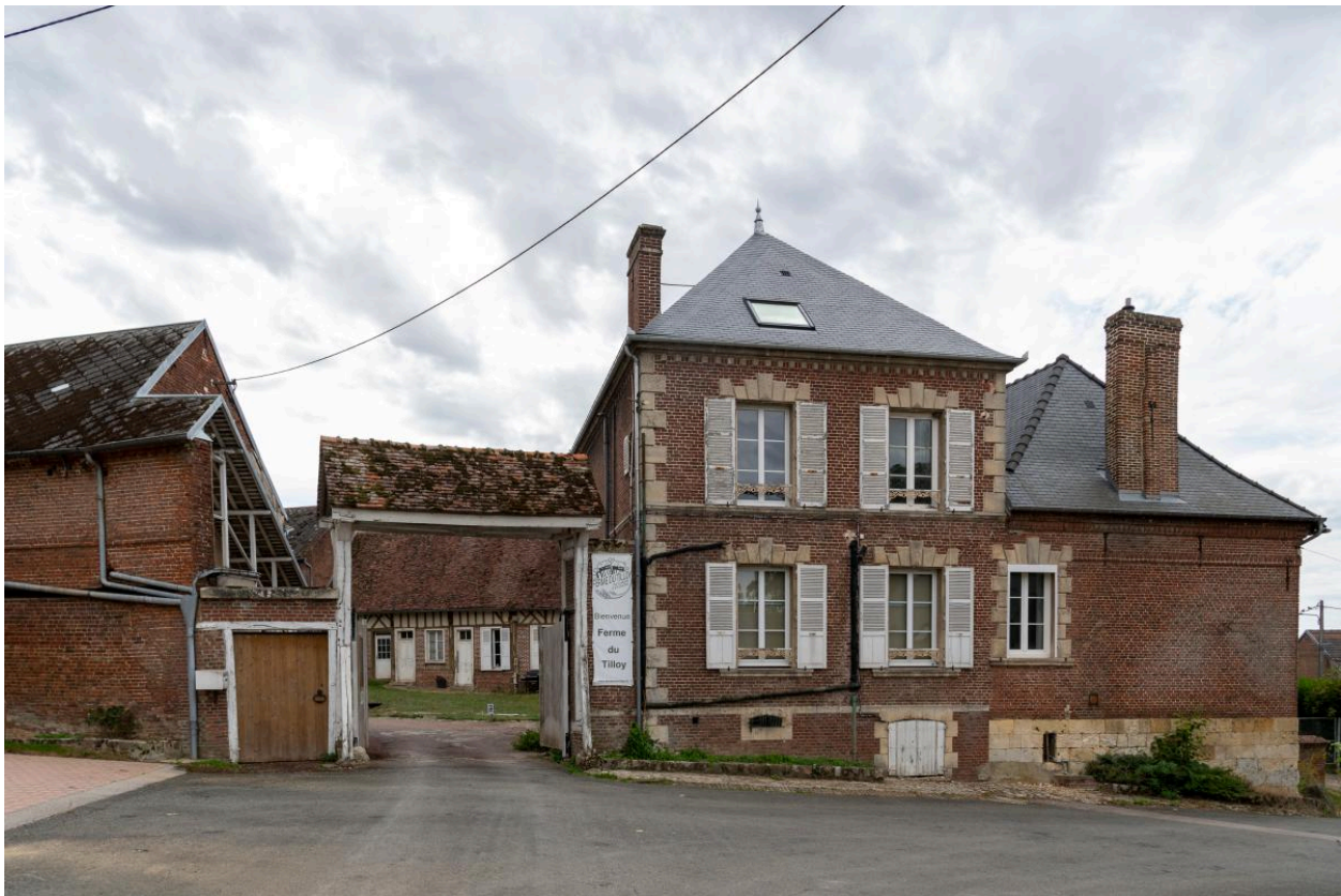
Entrée de la ferme côté logis du régisseur, vue depuis le nord.
