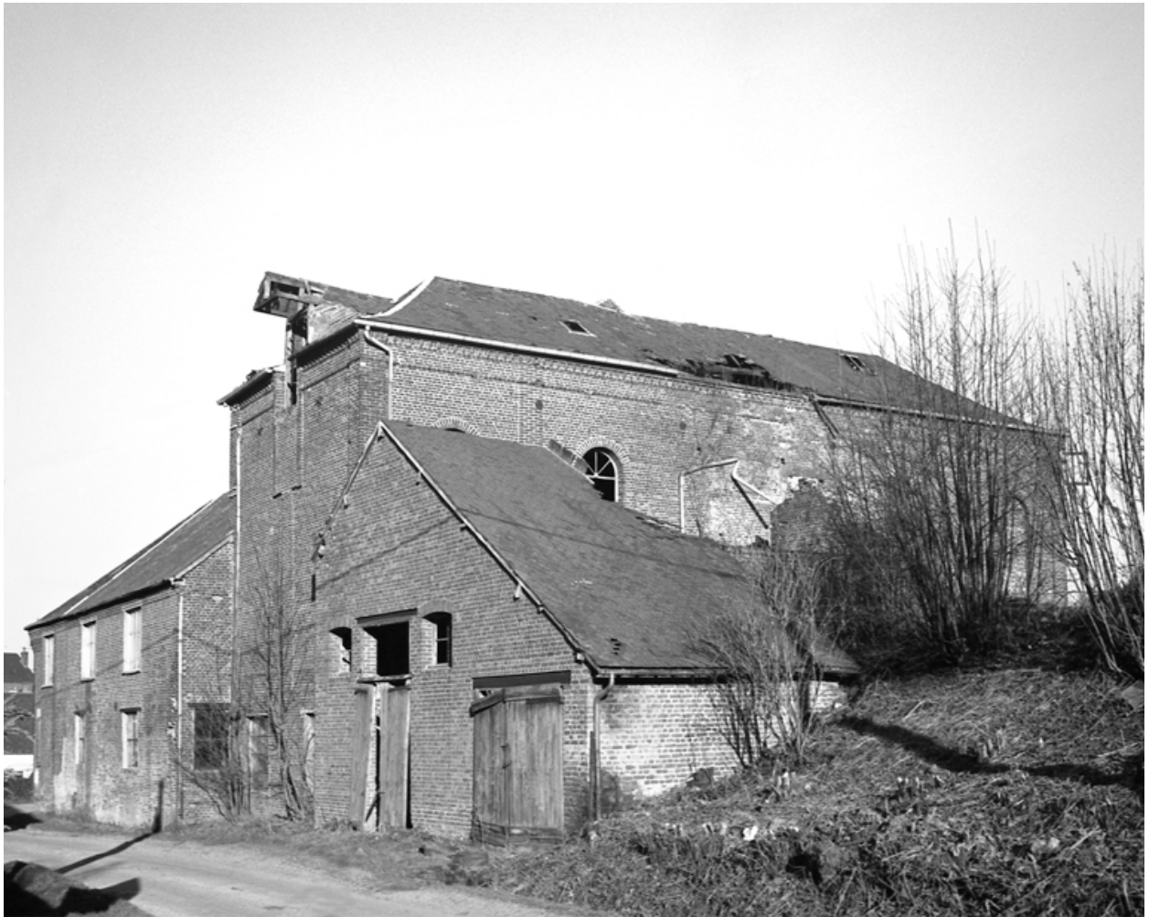
Vue générale de l'usine, prise depuis le sud-ouest.
