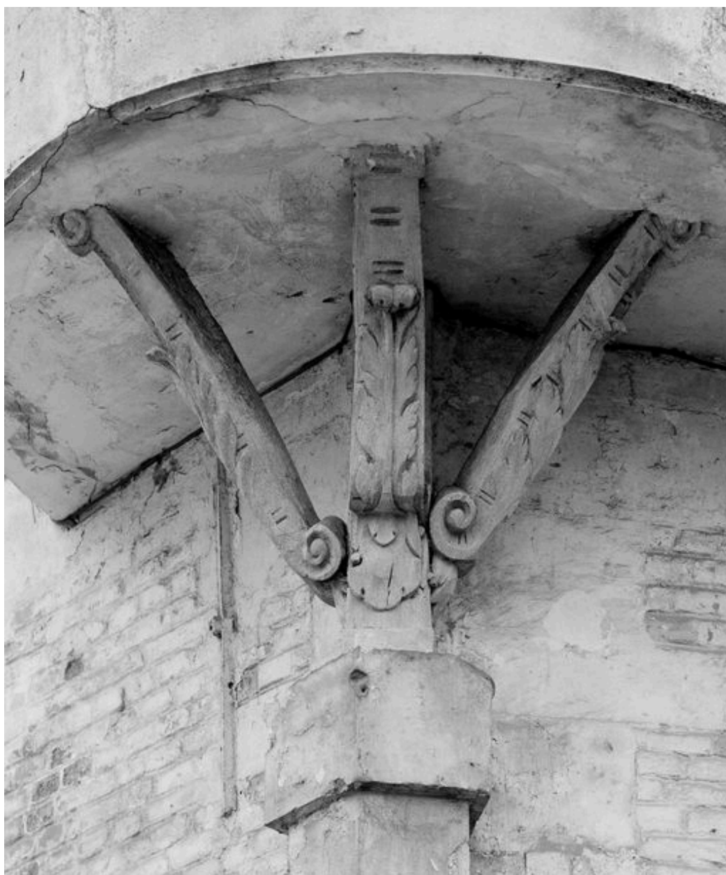
Détail des consoles de l'échauguette.
