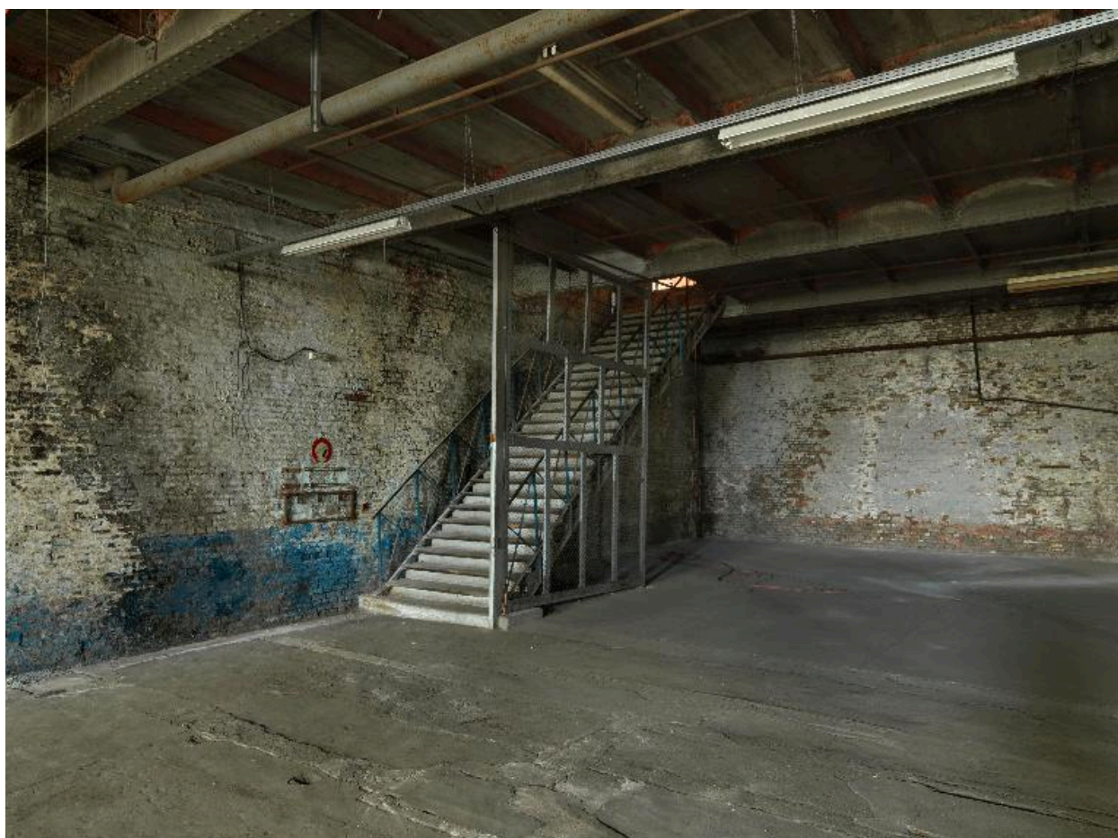
Escalier droit reliant les deux ateliers de tissages superposés.
