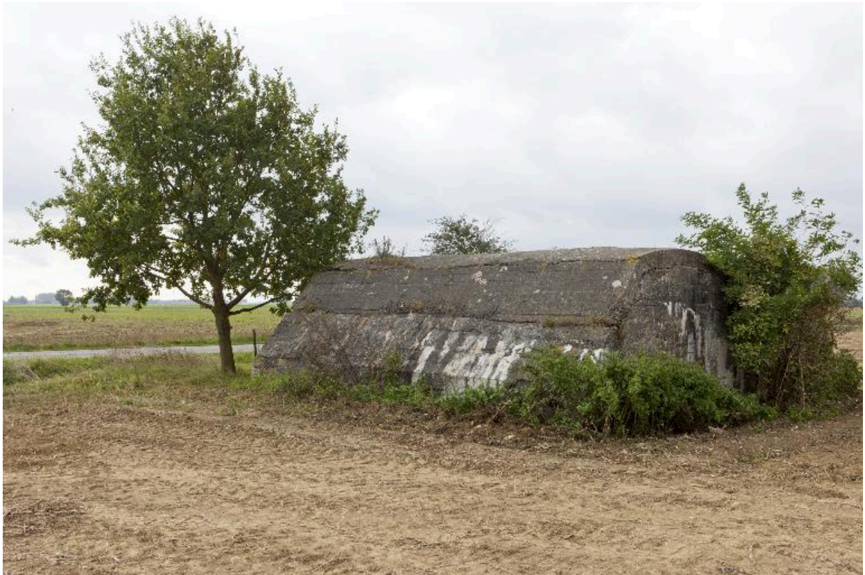
Vue générale, vers le sud
