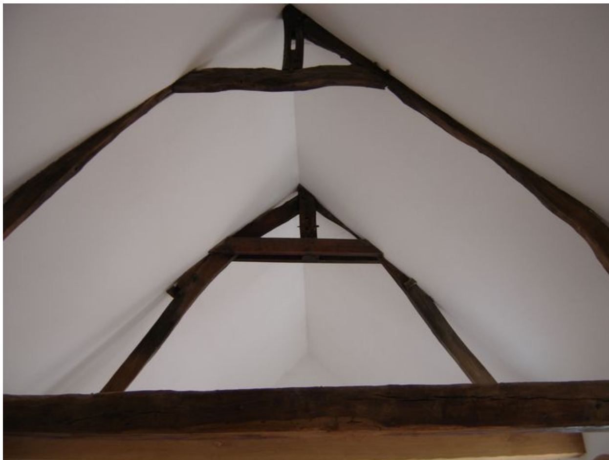
Vue de la charpente de l'ancienne grange.
