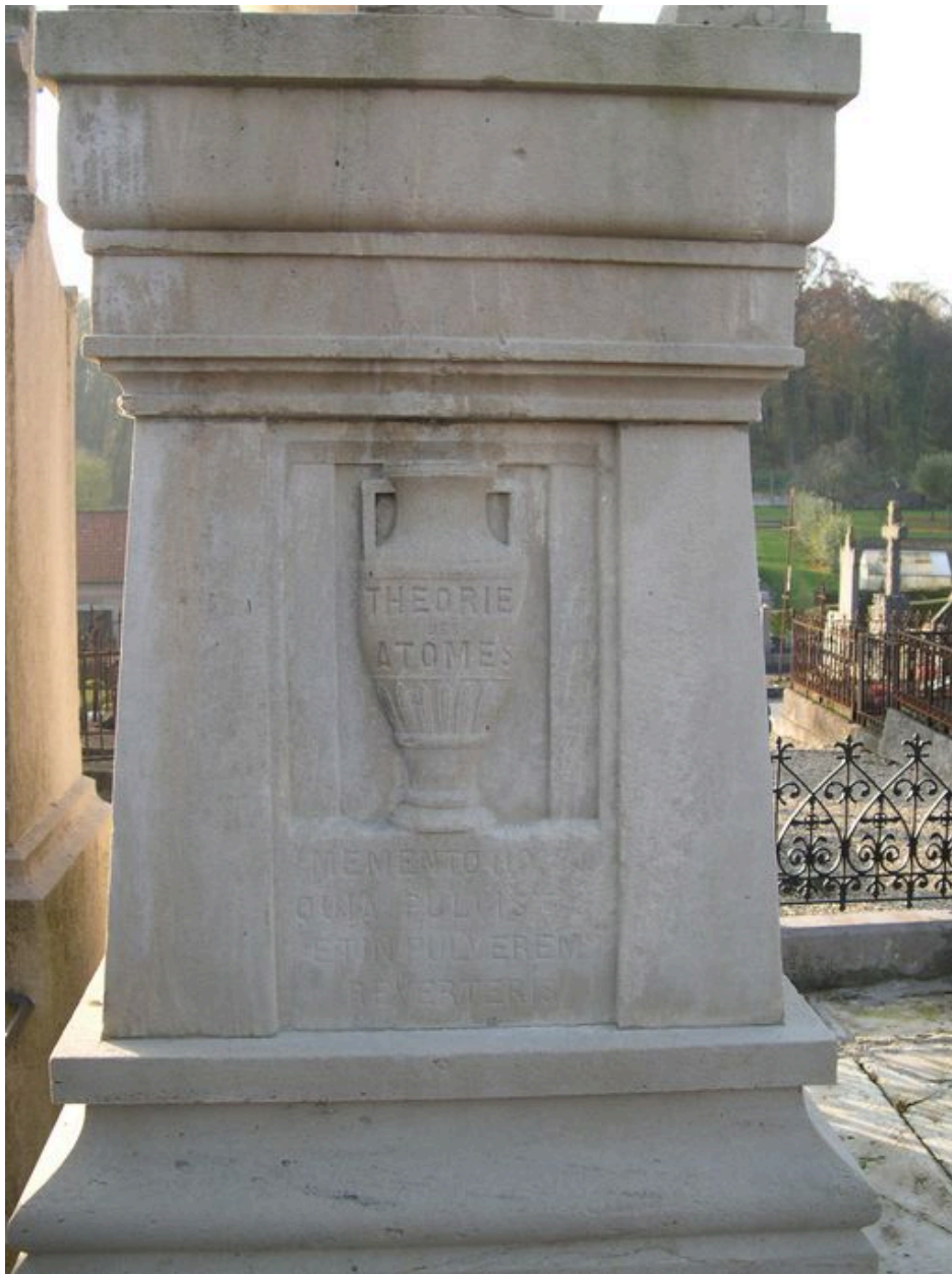
Vue de détail sur la face nord.
