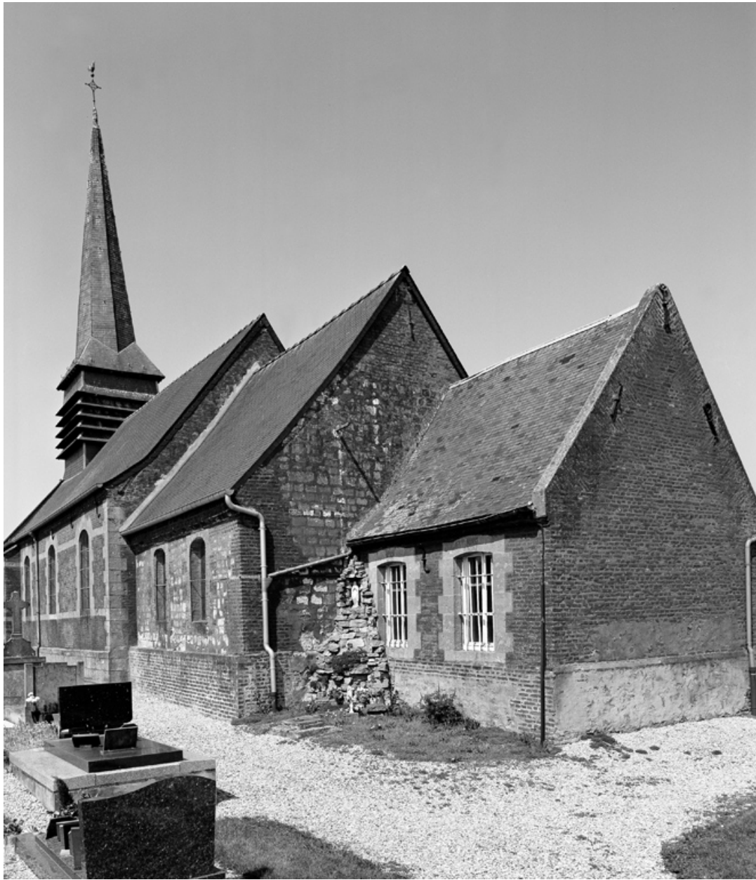
Vue générale de l'édifice, depuis l'est.
