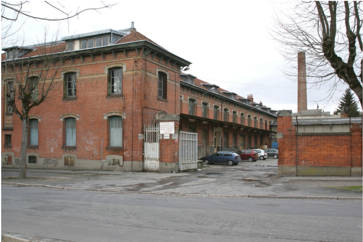
Entrée du site.
