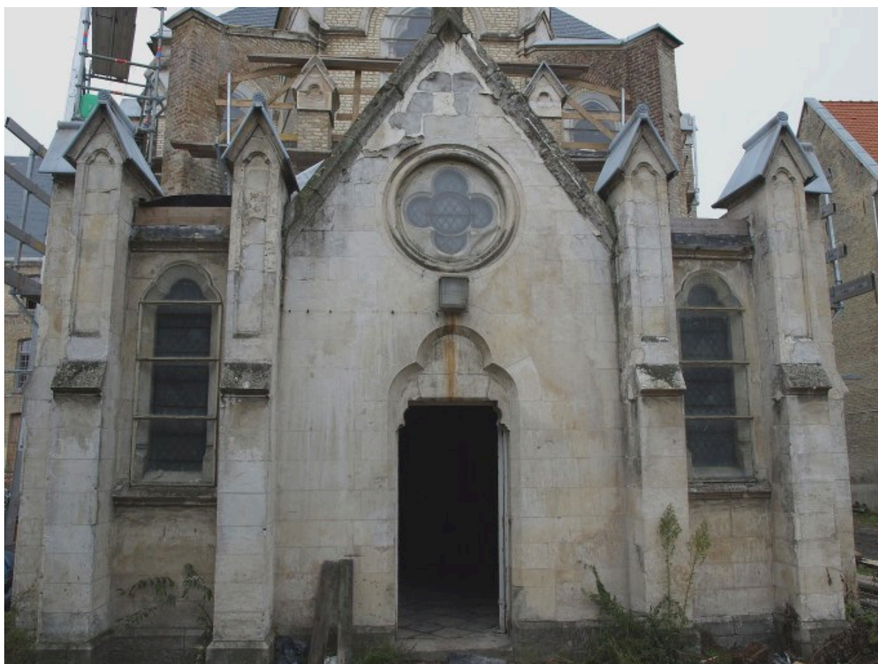
Chapelle, porche donnant accès à la sacristie
